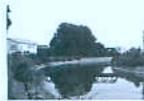
上流側から撮影
